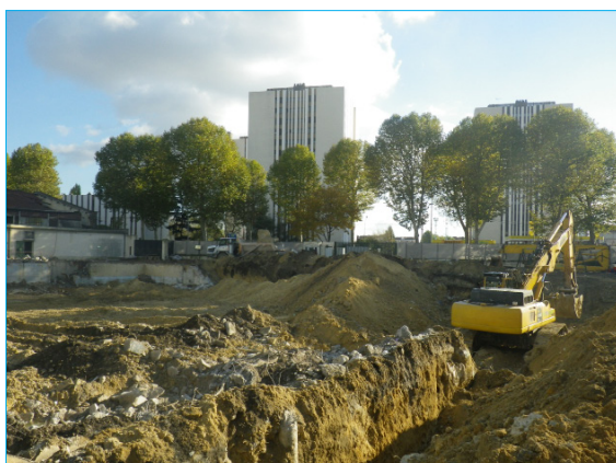
Chantier de démolition - dépollution, Noisy-le-Sec
